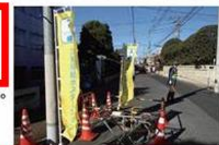
←消火栓からの応急給水
